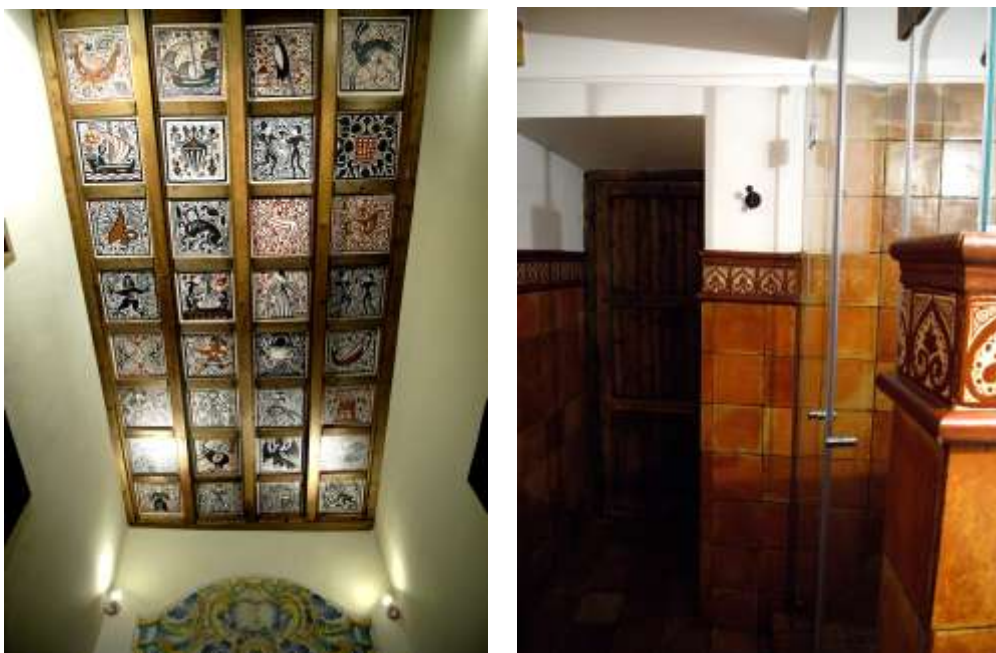
Dos ejemplos de aplicación del azulejo gótico de estilo “socarrat” en la construcción. Izquierda: Techo compuesto de placas de 40x40 cm montado sobre travesaños de madera. Derecha: Baño de estilo gótico-mudéjar compuesto por azulejos de terracota y una cenefa superior de “socarrats” de 10x10 cm y molduras. Vivienda particular.
