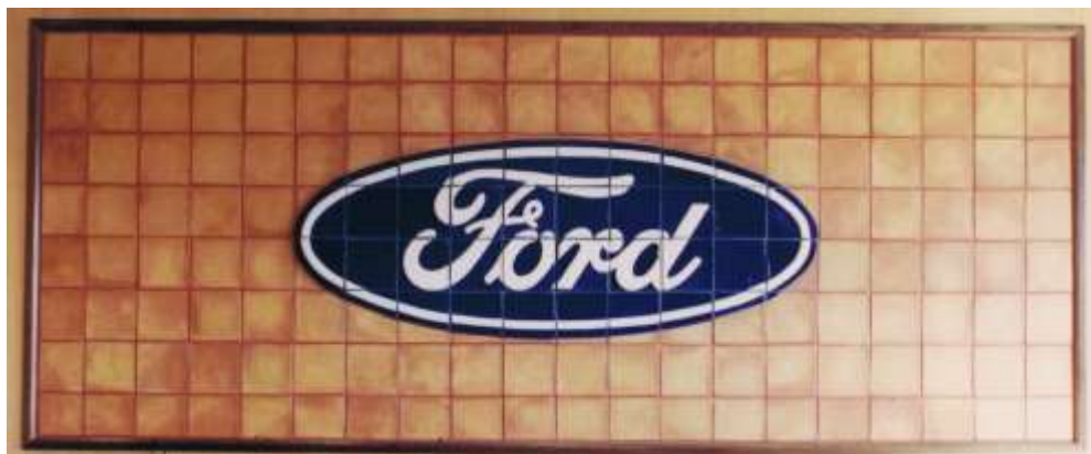
Rotulación realizada con azulejos de 20x20 cm esmaltado y recortado formando varias capas en relieve sobre una base de azulejo en terracota.
