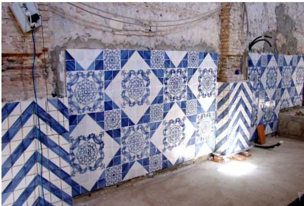
Instalación del zócalo de estilo barroco seriado, del siglo XVII en las obras de rehabilitación de la Iglesia de San Pascual en la localidad de la costa valenciana de El Perelló. Combinación de rosetones, azulejo blanco y azulejo pincelado en diagonal “mocadoret”. Proyecto desarrollado por LCV Gimeno.
