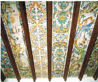
26. TECHO (detalle). Compuesto por planchas de 60x30 cm. Exposición de La Cerámica Valenciana.
